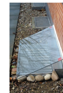
Установка светового прямки ACO Therm® с сетчатой решеткой, глубина 60 см, арт. 00460
