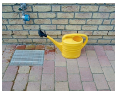
На фото дождеприемник (арт. 01581В) и решетка из нержавеющей стали (арт. 37273)
