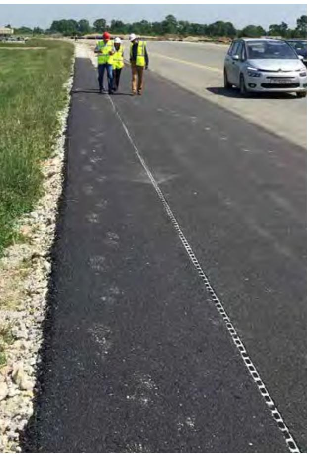
Установленная линия каналов
