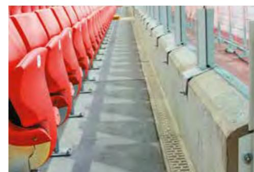
Система ACO Monoblock безопасна для кабелюков. Благодаря восемьмимиллиметровой ширине ячейки монолитной решетки, ACO Monoblock PD подходит для пешеходных зон.
