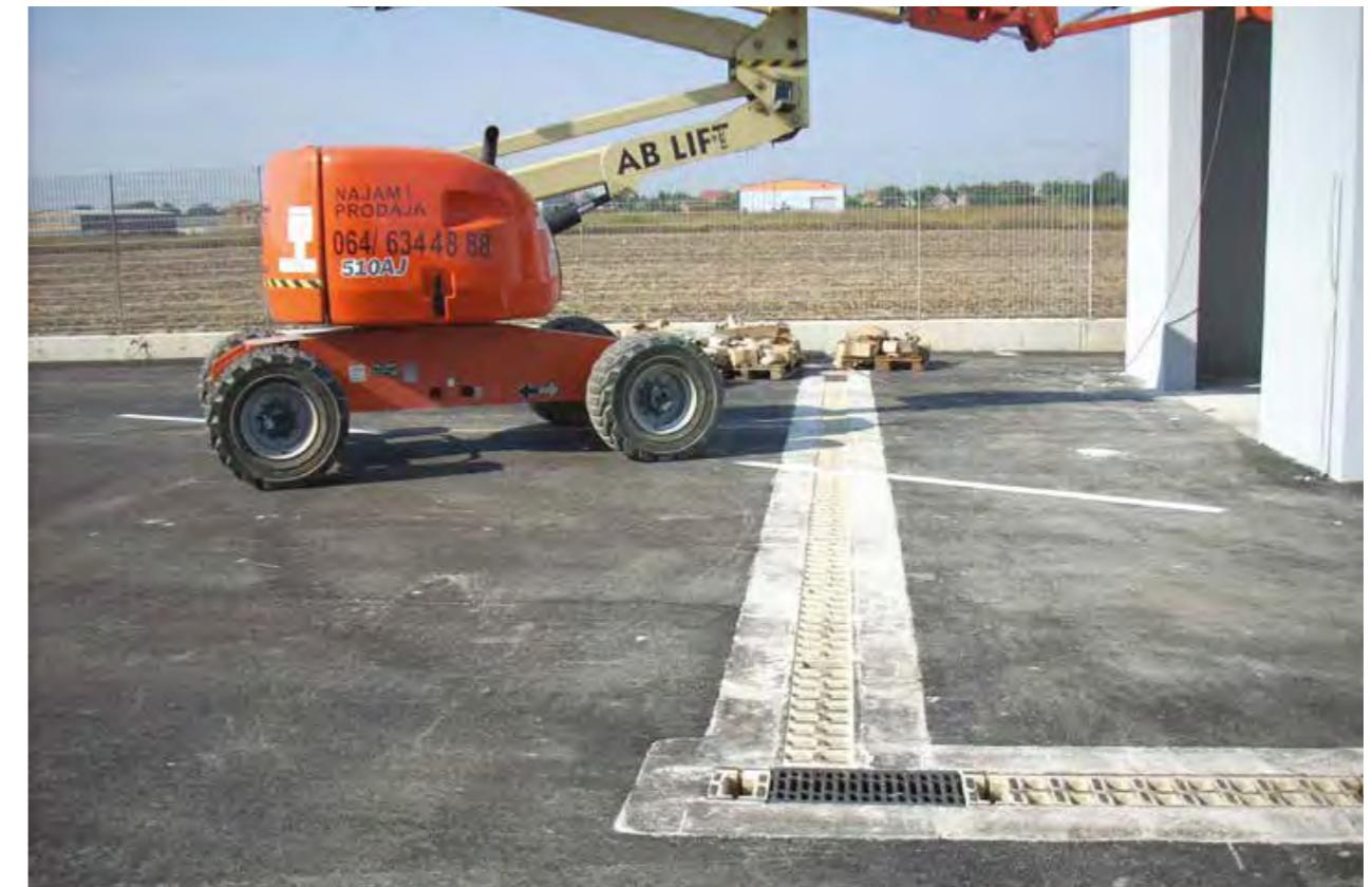
Каналы после укладки верхнего покрытия площадки
