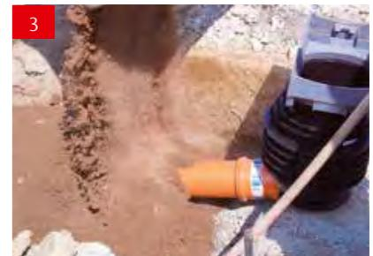
Забетонировать нижнюю часть корпуса бетоном класса B15
