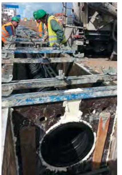
«Вывешивание» каналов перед заливкой бетонной обоймы. Армирование при необходимости
