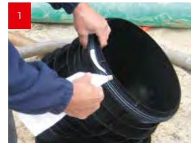
Перед монтажом модульных элементов на губчатый уплотнитель нанести смазывающий состав.
