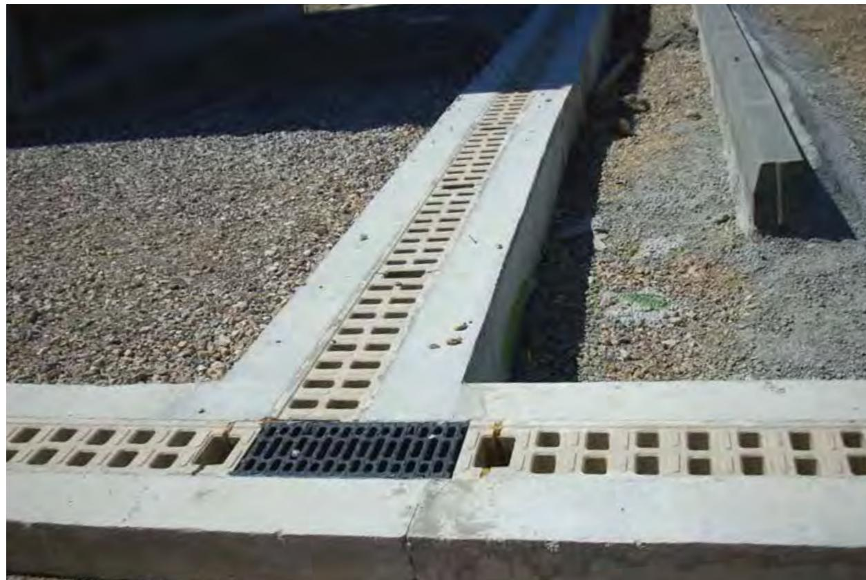
Каналы в бетонной обойме
