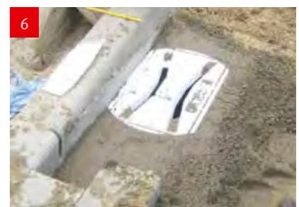
Корпус дождеприемника закрыть защитной накладкой и выполнить плиту распределения нагрузки из бетона класса B25.
