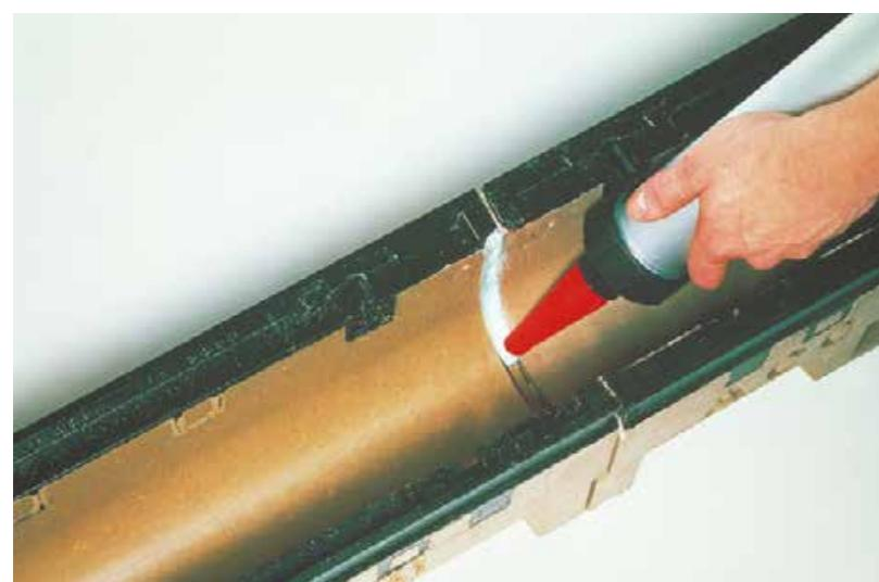
Нанесение герметизирующей массы
