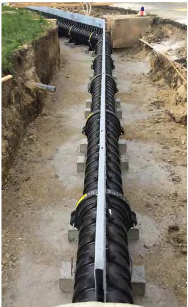
Бетонирование основания под ножки каналов
