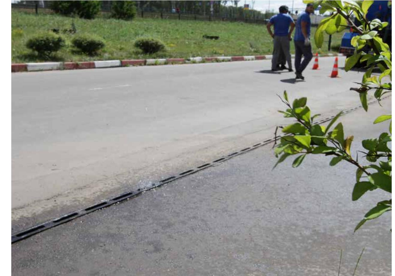
Канал в процессе промывки гидродинамическим способом
