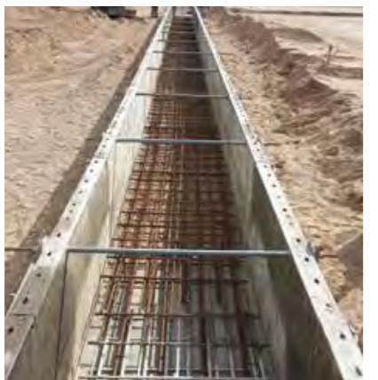
Устройство армированного бетонного основания
