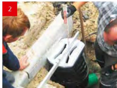
На подготовленное бетонное основание высотой 10-15 см произвести поэтапную установку отдельных модульных элементов с выверкой уровня на каждом этапе.
