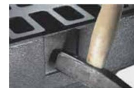
Закрывая чугунная рама в период строительных работ может быть открыта для временного водоотвода, Заглушки, уплотнительные прокладки и т.д. не требуются.
