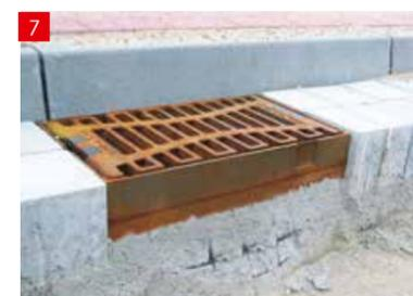
7. Корпус дождеприемника должен быть полностью защищен бетонной обоймой толщиной ок. 10-15 см.
