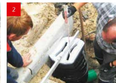
2. На подготовленное бетонное основание высотой 10-15 см произвести поэтапную установку отдельных модульных элементов с выверкой уровня на каждом этапе.
