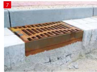
Корпус дождеприемника должен быть полностью заширен бетонной обоймой толщиной ок. 10-15 см.
