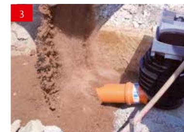
3. Забетонировать нижнюю часть корпуса бетоном класса B15
