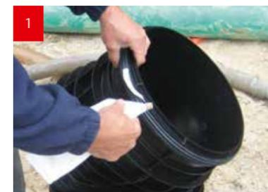
1. Перед монтажом модульных элементов на губчатый уплотнитель нанести смазывающий состав.
