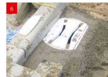
6. Корпус дождеприемника закрыть защитной накладкой и выполнить плиту распределения нагрузки из бетона класса B25. Плита распределения нагрузки должна быть на 30 мм выше верхней кромки корпуса дождеприемника.
