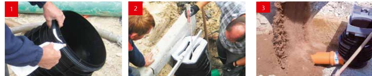
Перед монтажом модульных элементов на губчатый уплотнитель нанести смазывающий состав.
