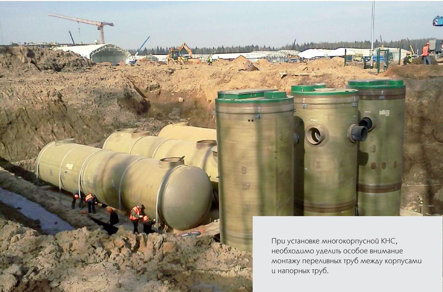
При установке многокорпусной КНС, необходимо уделить особое внимание монтажу переливных труб между корпусами и напорных труб.
