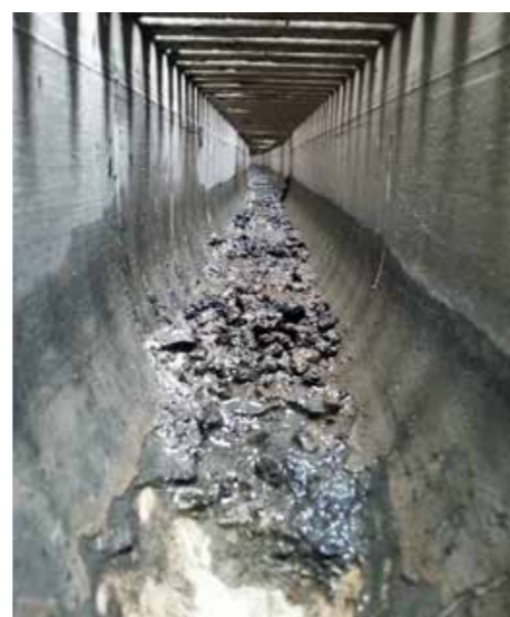
Канал до очистки
