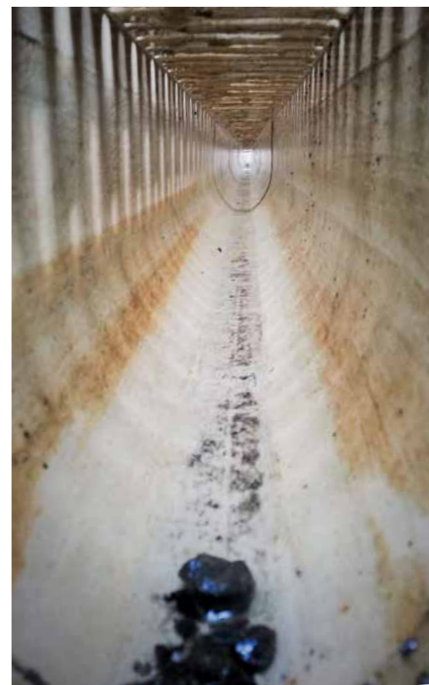
Канал после очистки
