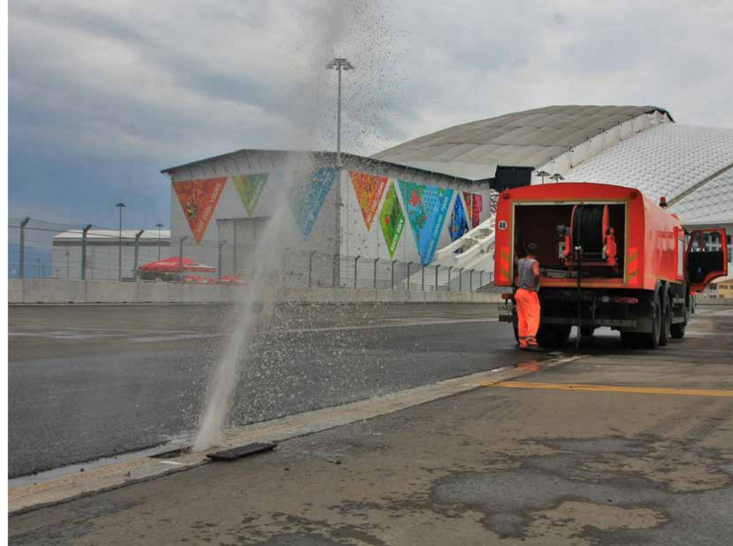
Канал в процессе прочистки гидродинамическим способом
