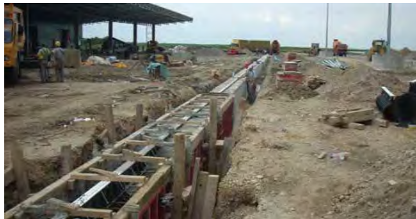
Устройство армированного бетонного основания
