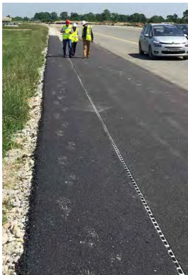
Установленная линия каналов
