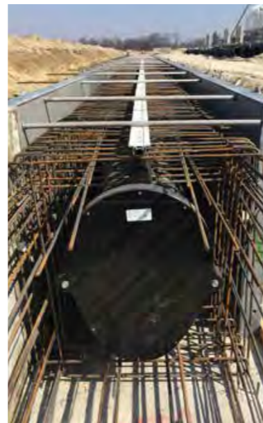
«Вывешивание» каналов перед заливкой бетонной обоймы. Армирование при необходимости
