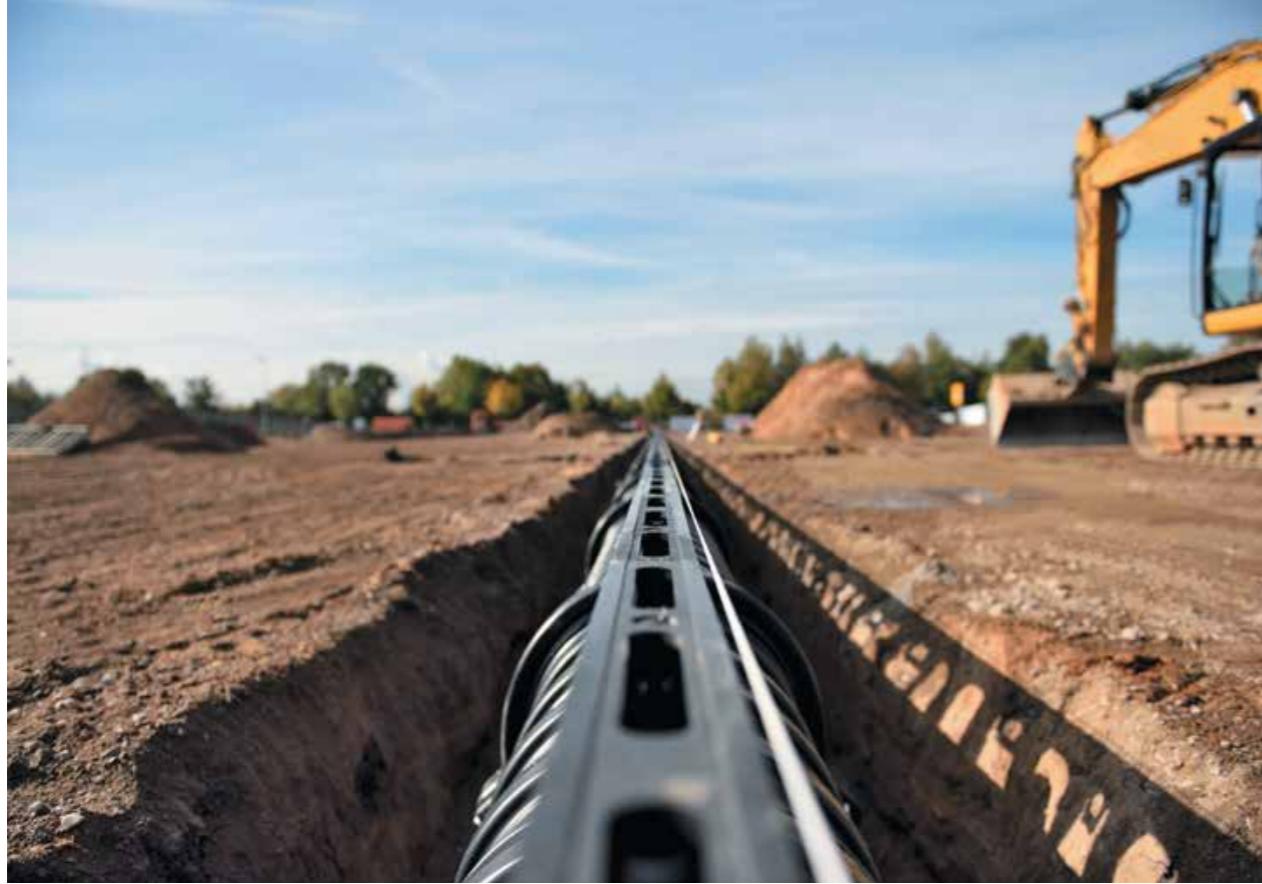
Складской комплекс 103 м каналов ACO Qmax 700
