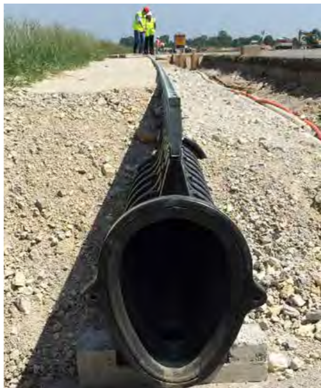
Засыпка ПГС с послойным уплотнением
