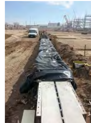
Устройство бетонной обоймы каналов ACO Qmax
