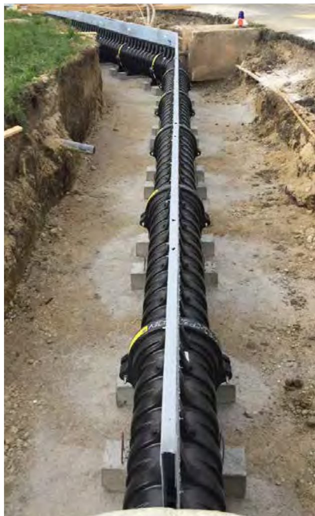
Бетонирование основания под ножки каналов
