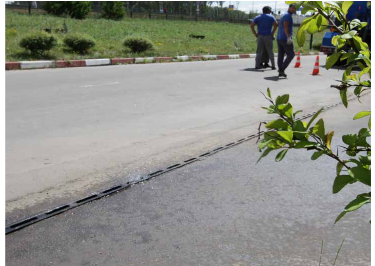
Канал в процессе промывки гидродинамическим способом
