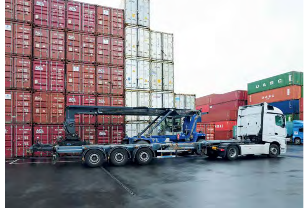
Установка на площадке контейнерного терминала 210 м каналов ACO Qmax 550/700
