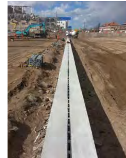
Устройство бетонной обоймы каналов ACO Qmax
