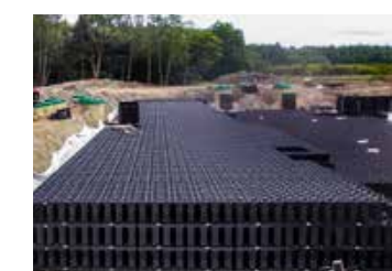
Автомобильный кластер, Калининград, ЛОС с резервуарами ACO StormBrixx
