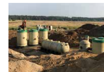
Центральная кольцевая автодорога Комлекс ЛОС и КНС для 5го пускового комплекса, Московская обл.
