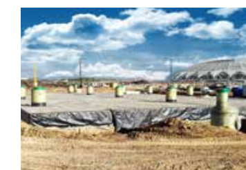
Стадион "Самара Арена" Комплекс КНС и ЛОС с резервуарами ACO StormBrixx
