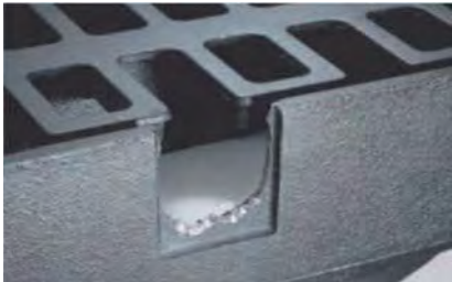
Временный водоотвод в период строительства находится посередине стенки рамы, таким образом, грязь не попадает на петли.
