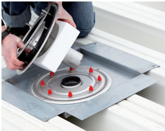
Воронка из нержавеющей стали для плоских кровель с двумя слоями гидроизоляции
