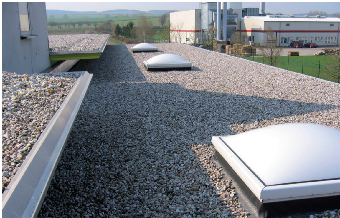
Плоская кровля с защитным слоем гравия
