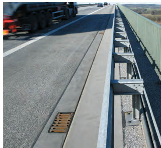
Развязка Москва-Минск, Воронка ACO для мостов
