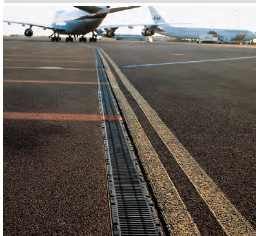
АП Домодедово, системы ACO SK
