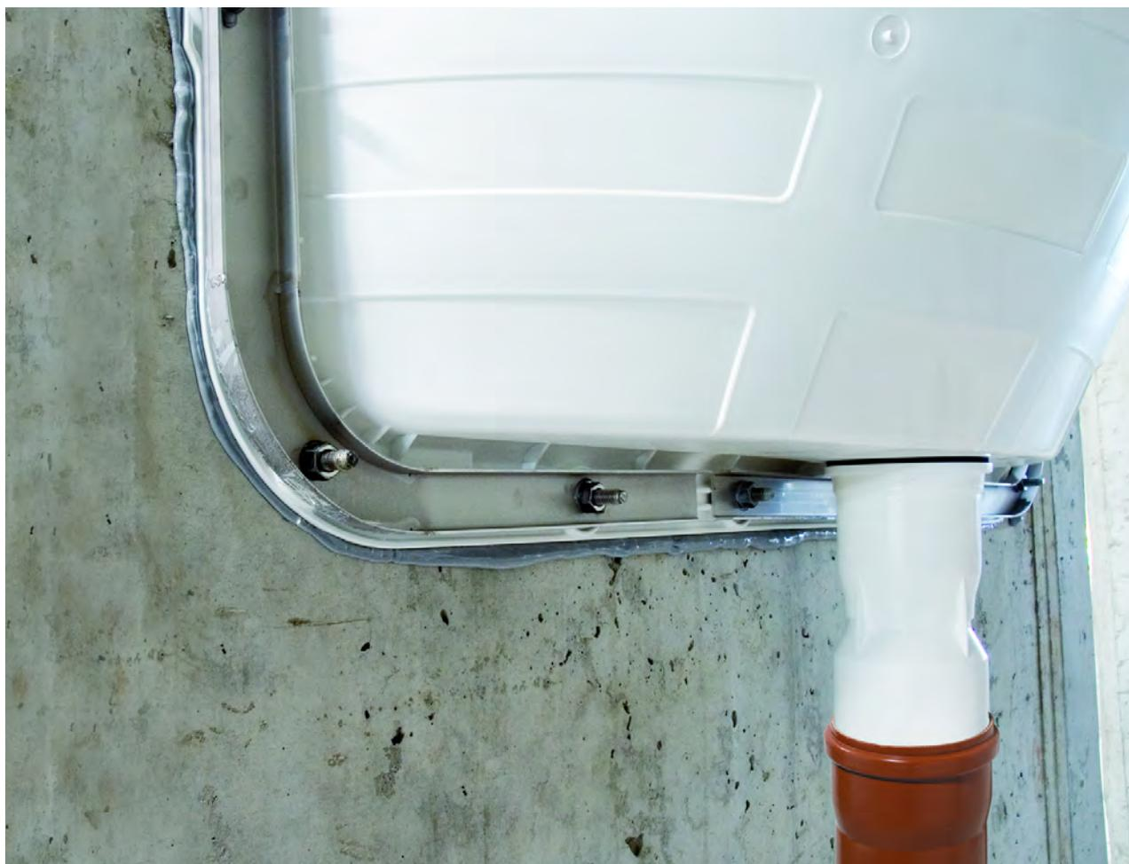
\* - герметичный монтаж возможно выполнить и без использования прижимной планки. При этом необходимо использовать дюбели и болты из нержавеющей стали.
