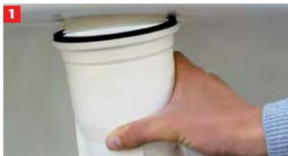
1 В отверстие с внутренней стороны приемка вставить верхнее кольцо выпускного элемента. С наружной стороны приемка к верхнему кольцу прикрутить нижнюю часть выпускного элемента.
