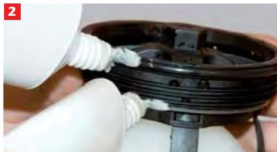
2 Нанести герметик на резьбовое кольцо обратного клапана. Подойдет любой сантехнический герметик.\*
