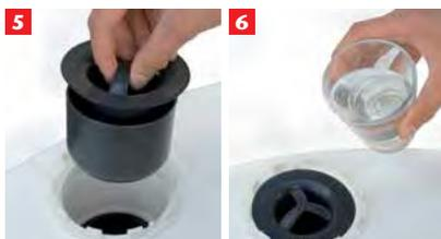
5 В верхнее опорное кольцо установить сифоном (при наличии) и залить в корпус сифона ок. 0,5 л воды для создания гидрозатвора.
