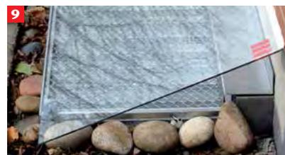
9 Для предотвращения попадания воды в приемок можно использовать защитные крышки - см. стр. 17-18. В этом случае отверстие в корпусе приемка можно закрыть с помощью специальной крышки (см. арт. 35583 на стр. 22)
