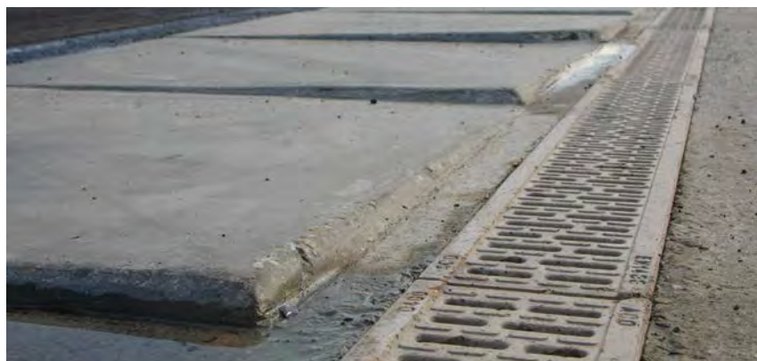
Торцевые заглушки глухие ACO Monoblock PD 100 натурального и черного цвета
