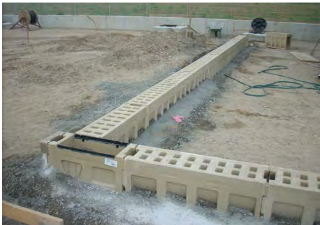
■ Устройство Г-образного соединения каналов
