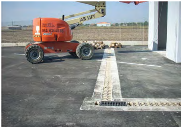
■ Каналы после укладки верхнего покрытия площадки
