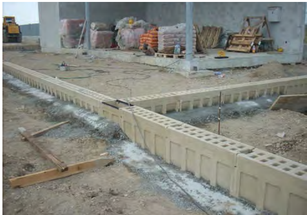
■ Устройство Т-образного соединения каналов
