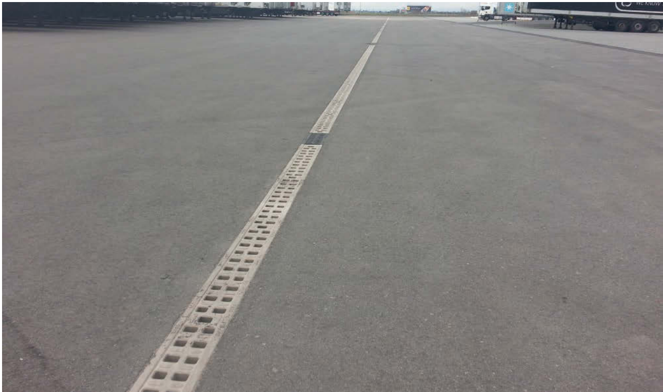
■ Пример установленной линии каналов
