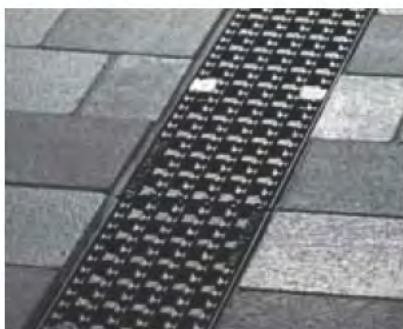
Решетка продольно-поперечная (чугун)
